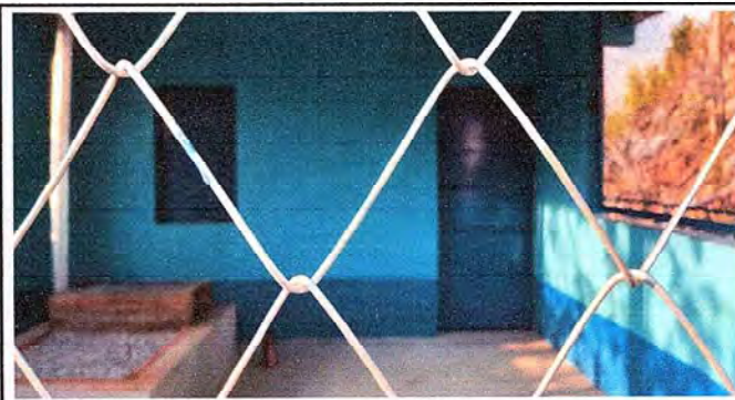
FOTO 4: COLOCACIÓN DE LA PILETA DE LA COCINA: Se evidencia el 85% del trabajo.
