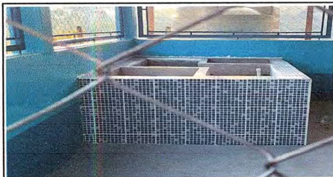
FOTO 3: EL EQUIPAMIENTO DEL PROYECTO DE COCINA: El avance se evidencia el 80%.
