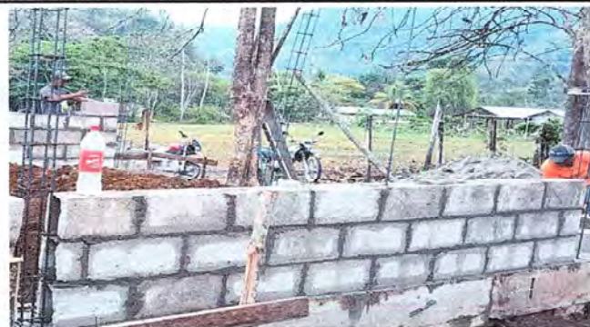
FOTO 2: EL AVANCE DE LA REMODELACIÓN DE LA COCINA: La ejecución lleva un proceso del 50%.
